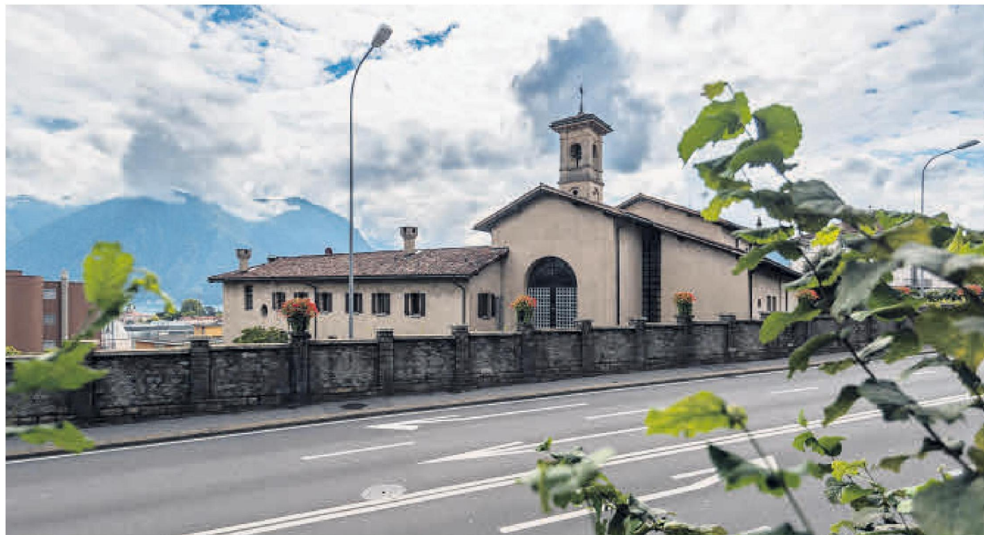
Prima di un paio d'anni il cantiere non dovrebbe iniziare.
